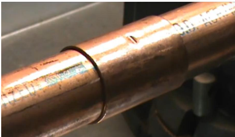
Hình 30: Chuẩn bị hàn nối hai ống có đường kính bằng nhau
