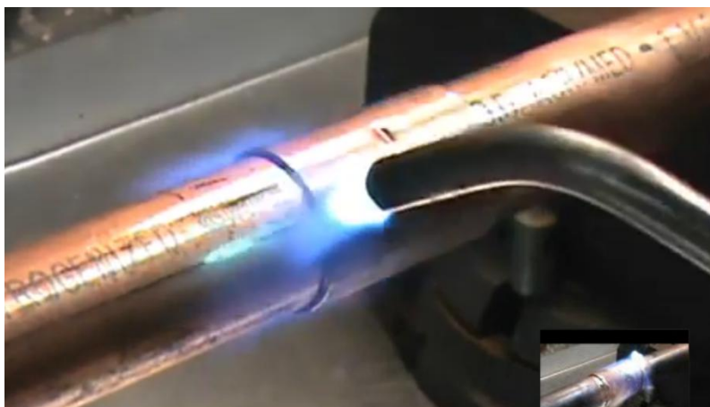
Hình 31: Hàn nối hai ống có đường kính bằng nhau
